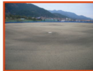
東山高等学校健甕総合グラウンド エコクレイTSリサイクル工法
