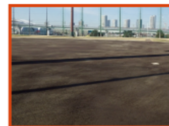
江東区夢の島野球場 エコクレイTSリサイクル工法
