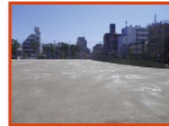
江戸川区立船堀小学校運動場 エコクレイTS現場プレミックス工法
