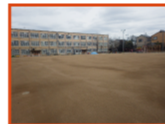
京都市立藤ノ森小学校運動場 エコクレイTSリサイクル工法
