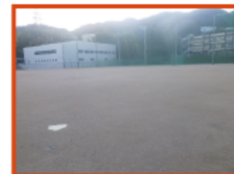
大阪青凌中学校・高等学校島本学舎グラウンド エコクレイTS現場プレミックス工法
