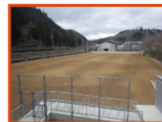
殿田中学校グラウンド エコクレイTS現場プレミックス工法
