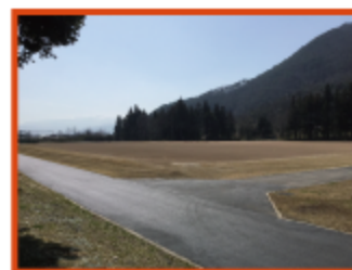
十六沼公園ソフトボール場 エコクレイTSリサイクル工法
